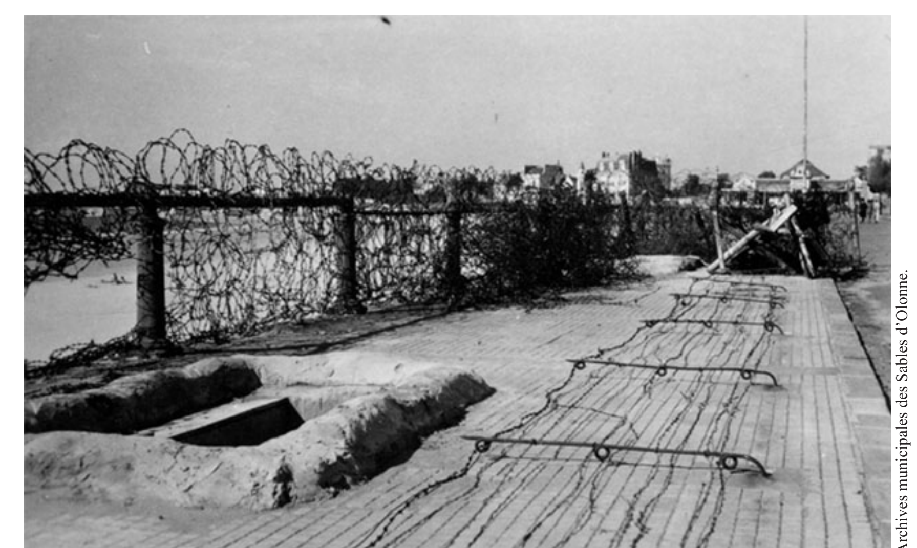
Casemates et barbelés sur le remblai des Sables dont l'accès est interdit
