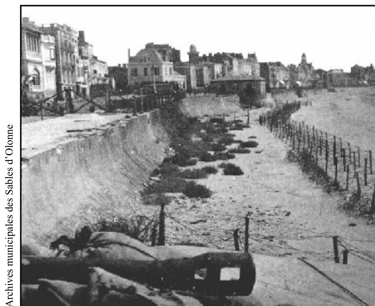
Le remblai des Sables d'Olonne et les défenses préventives face à un éventuel débarquement
